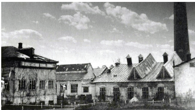
Здание Первомайской ткацкой фабрики
